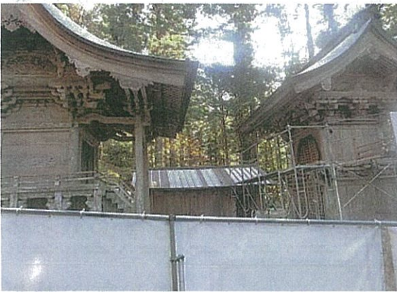
本殿・拝殿 舞台撤去
