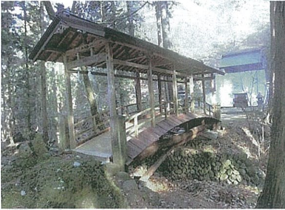
下馬橋修繕 (梁の補強、床板の張替、下屋の新設)
